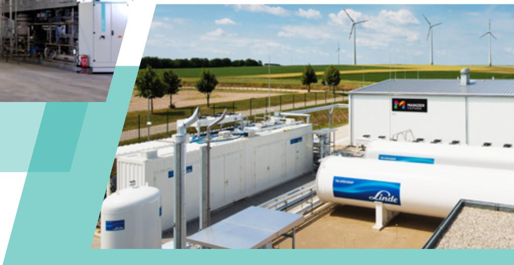
Drei PEM-Elektrolyseure liefern Energie von je zwei Megawatt. Mittels eines ionischen Verdichters lässt sich der Wasserstoff mit höherem Druckniveau speichern.
