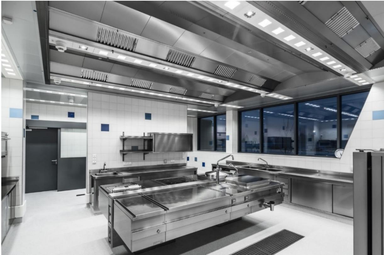
Abbildung 14: Lüftungsdecke in einer Zubereitungsküche
