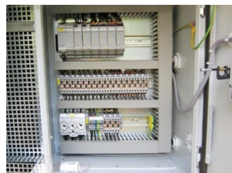
Abbildung 12: Messtechnik in einer Ortsnetzstation von Stromnetz Berlin
