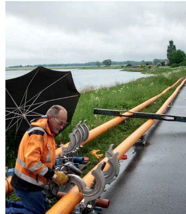
Schweißerarbeiten am Breitling auf der Insel Poel
