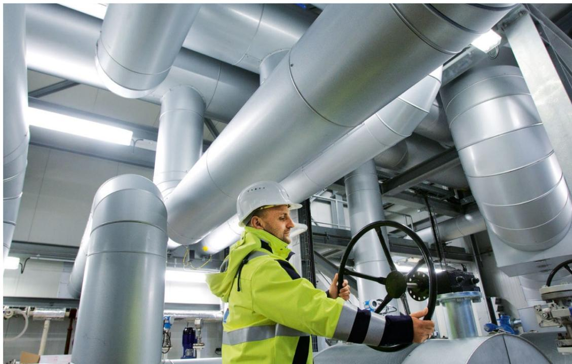
Heißwasserleitungen im Industriekraftwerk Greifswald für den Wärmetransport zur Anlandestation der Nord Stream.
