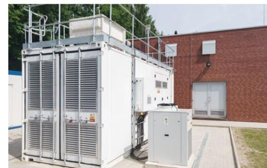
Oben und unten: Herzstück der Anlage ist der Elektrolyseur. | Fotos: innogy
