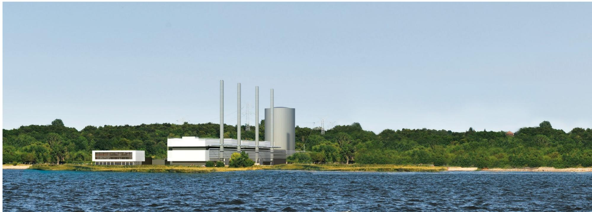
Zur Heizperiode 2018 wird das neue Gasmotorenheizkraftwerk am Kieler Ostufer seinen Betrieb aufnehmen. Das runde Gebäude in der Bildmitte ist der 60 Meter hohe Wärmespeicher. Links im Bild befindet sich die Leitwarte, über die das Kraftwerk gesteuert wird. | Visualisierung: Stadtwerke Kiel
