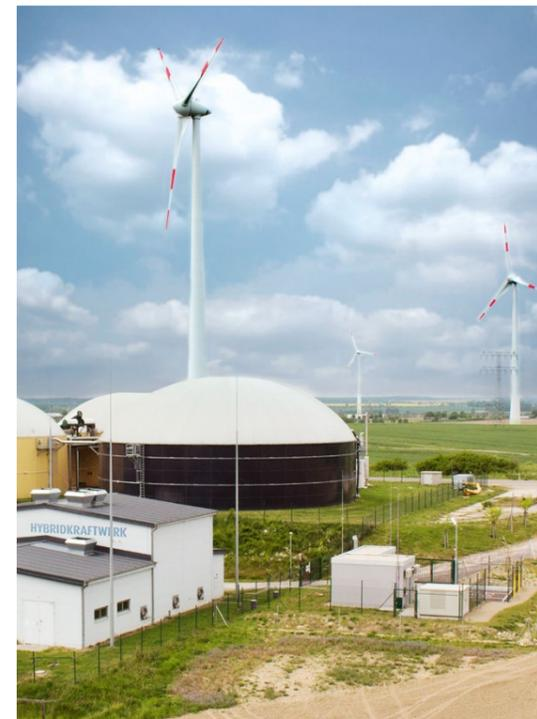
Die Power-to-Gas-Anlage der enertrag AG in Prenzlau (links im Bild) speist mit Windstrom erzeugten Wasserstoff ins ONTRAS-Netz (kleines Gebäude rechts). | Fotos: ONTRAS GmbH
