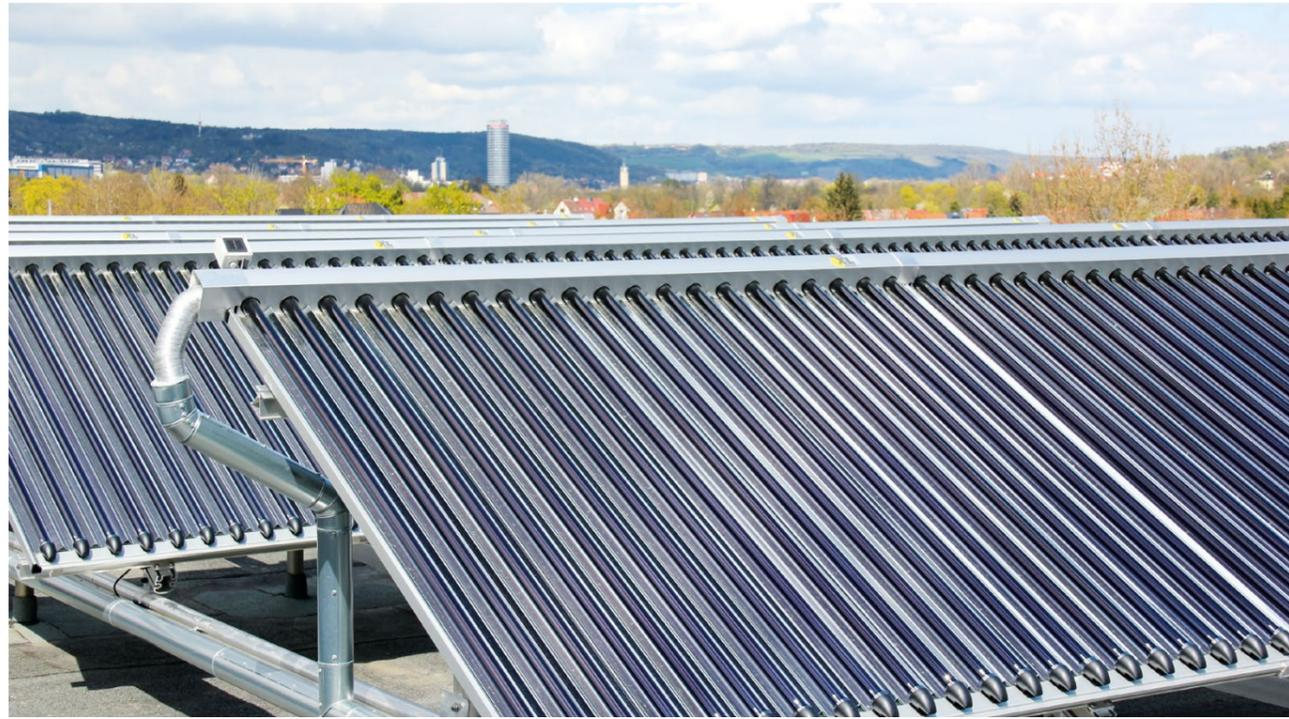
Die Röhrenkollektoren auf dem Dach einer Fernwärmestation speisen ihre Energie ins Wärmenetz ein.
