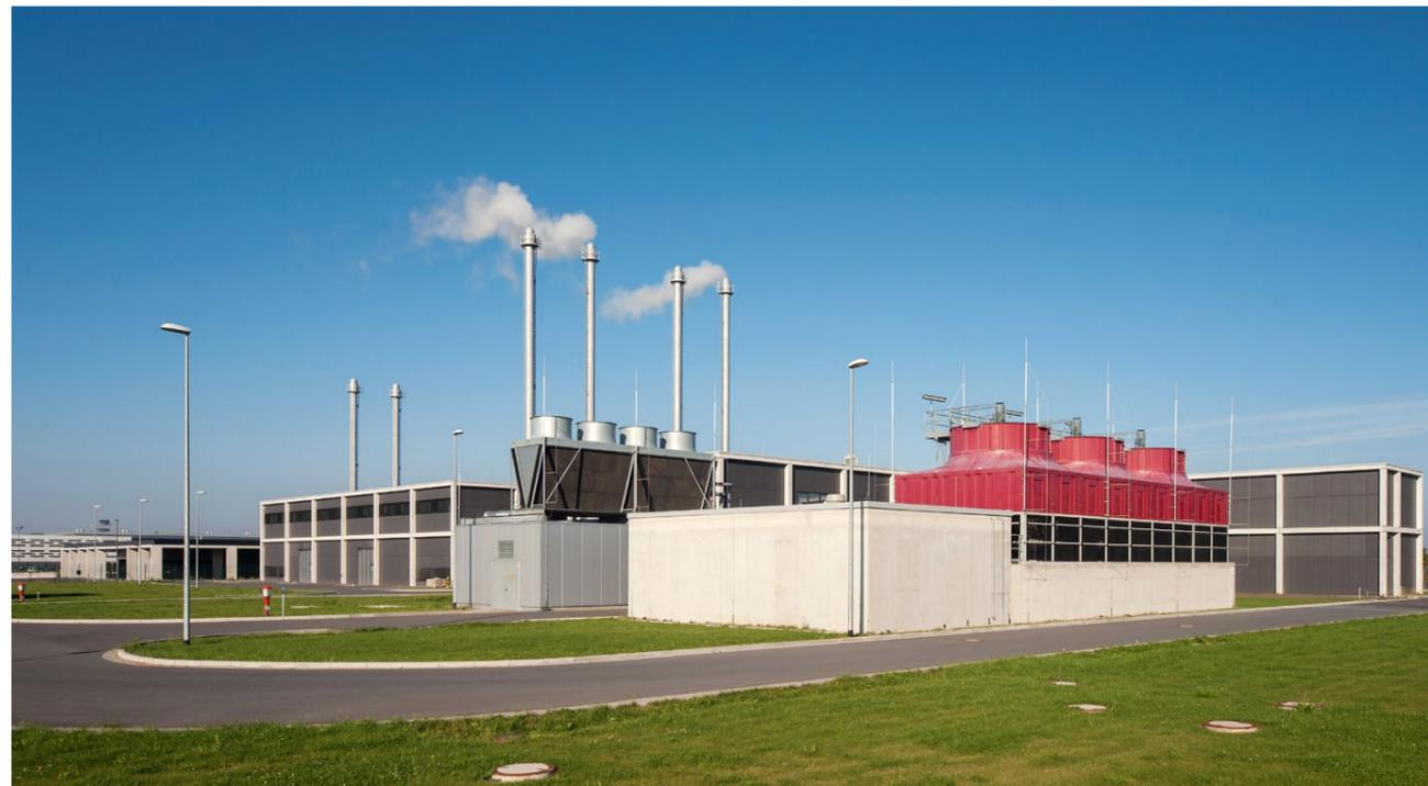
Oben: Die Energiezentralen erzeugen Wärme, Kälte und BHKW-Strom für die Flughäfen Schönefeld (alt) und BER (neu).
