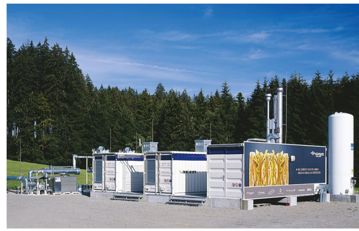
Die Thüga Energie GmbH hat in Kißlegg eine Biogas-Aufbereitungsanlage errichtet. Das Rohgas aus Speiseresten und Reststoffen liefert die BRV Biologische Reststoff Verwertung GmbH.
