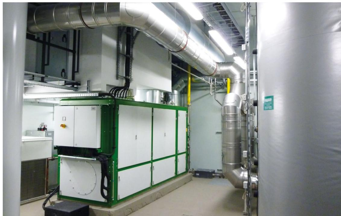
Die Blockheizkraftwerke sind sechs Meter unterhalb der Erdoberfläche installiert. | Foto: RheinEnergie AG
