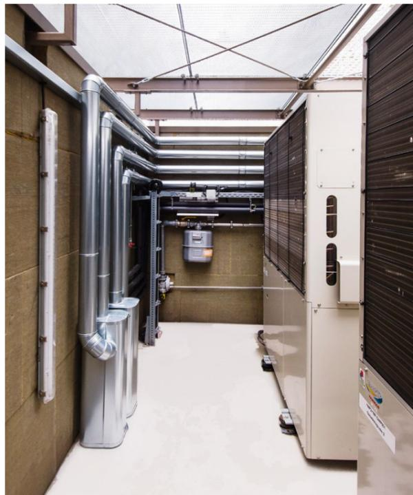
Zwei Gasmotor-Wärmepumpen erzeugen Wärme und Kälte für das Amtsgericht.
