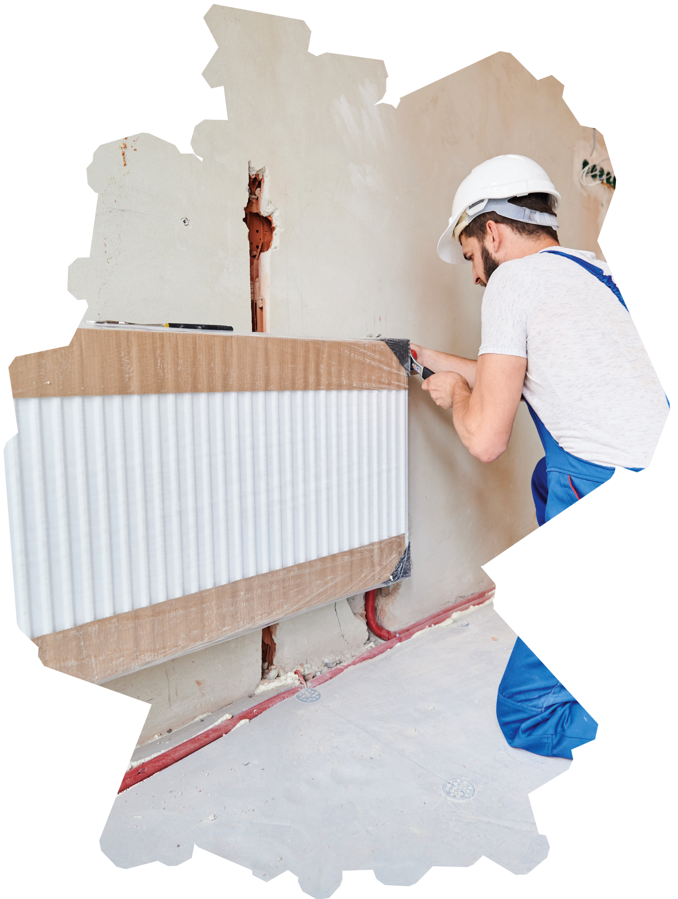
Im Zuge einer Heizungserneuerung kann auch ein Energieträgerwechsel sinnvoll sein.
