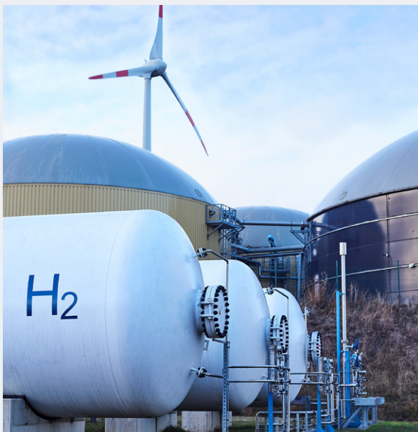
Außenansicht eines Hybridkraftwerks, Foto: BDEW/Swen Gottschall
