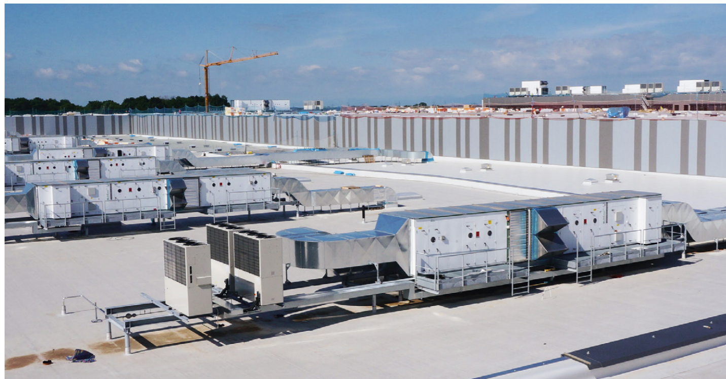
Auf dem Dach des Zalando-Logistikzentrums in Lahr im Schwarzwald verrichten 81 Gasmotorwärmepumpen ihren Dienst. | Foto: KKU CONCEPT GmbH
