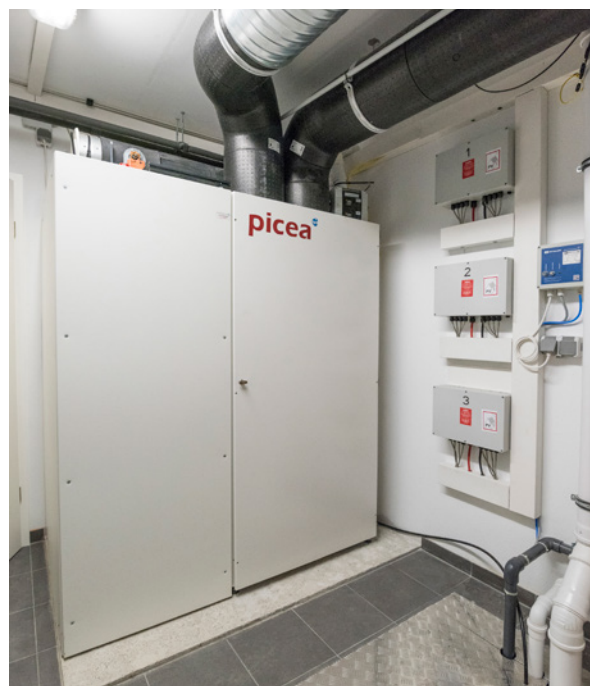
Wasserstoff-Energiezentrale, HPS
