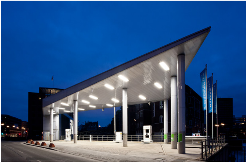
Wasserstofftankstelle HafenCity in Hamburg, Vattenfall
